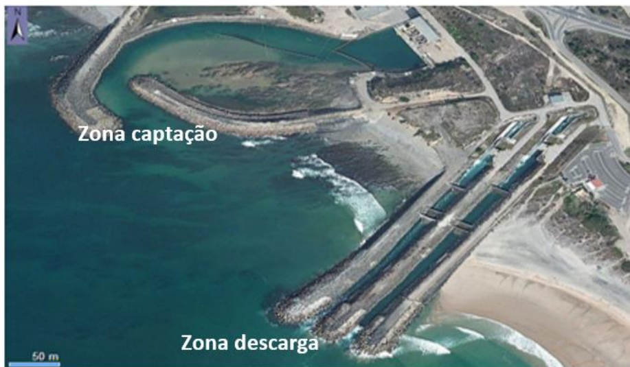
Figura 3: Infraestruturas de captação e rejeição do Sistema de refrigeração da Central Termoelétrica de Sines.
